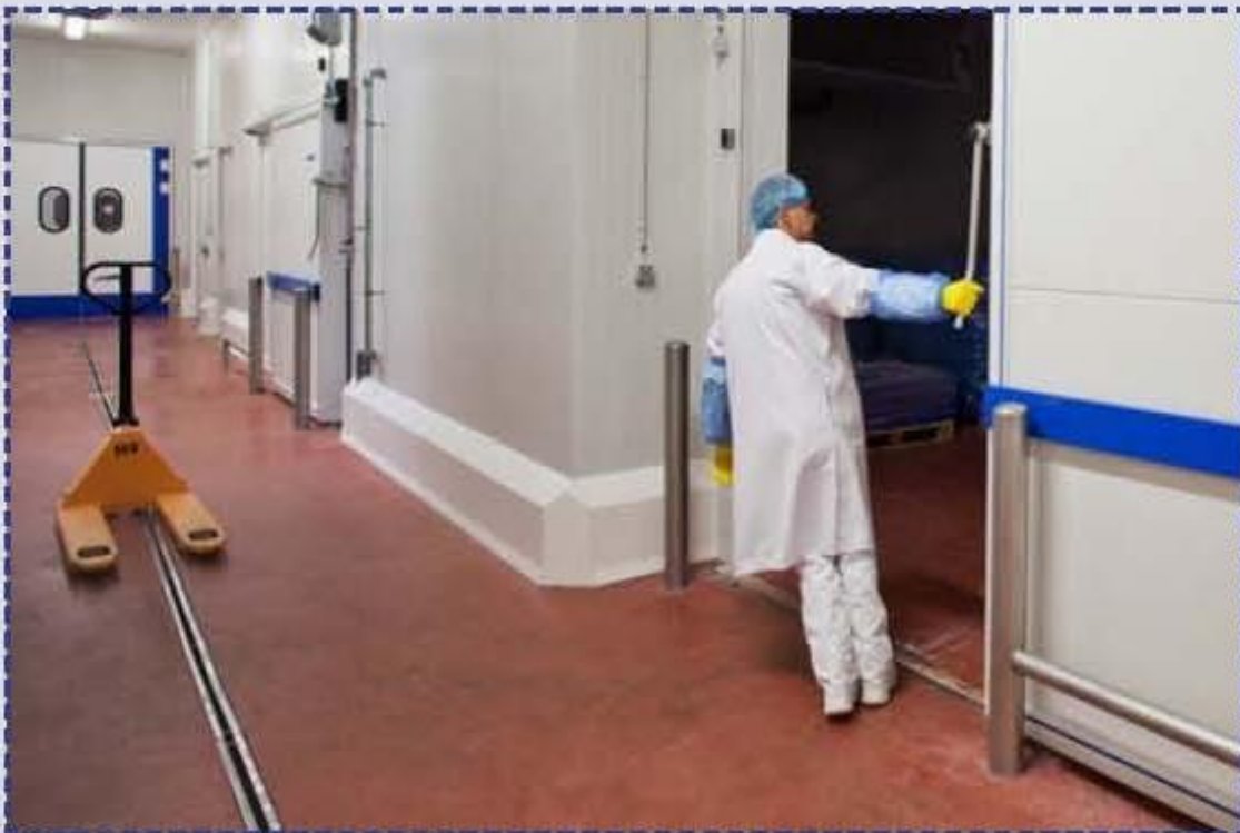
Zócalos PolySto IP40F y postes y barrera instalado e introducido e suelo de hormigón.
