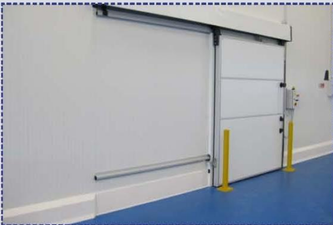
Zócalo PolySto OP30F, OP30SF tipo Sanicoat y poste de poliuretano instalado en suelo de epoxy.
