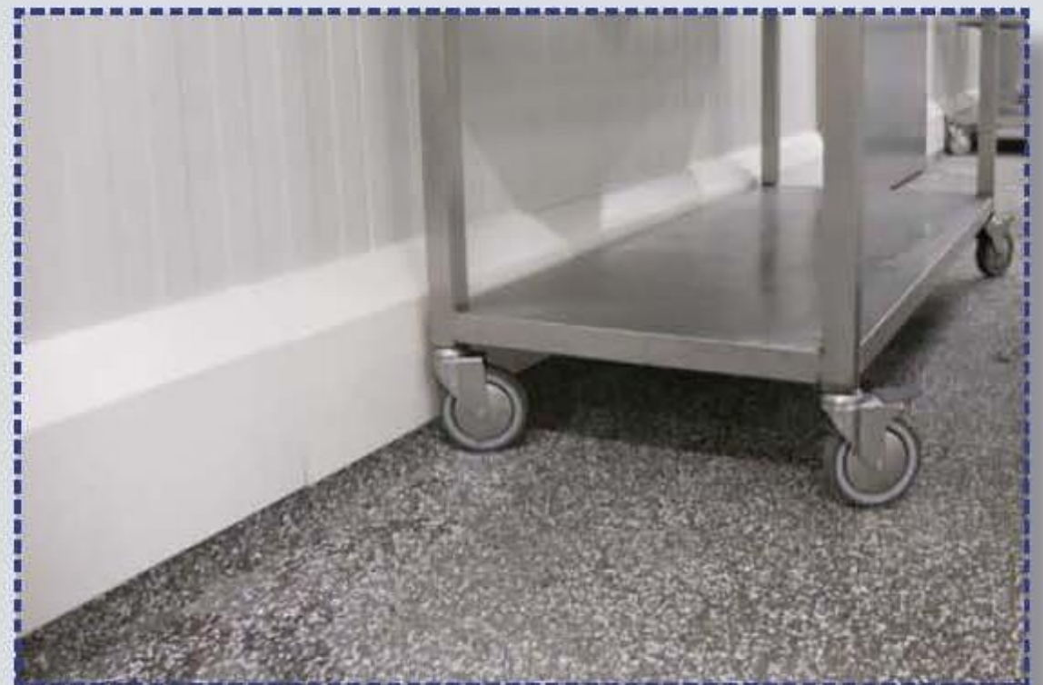
Zócalo PolySto OP30RB instalado en suelo de granito aplicado en el zócalo con rebaje.
