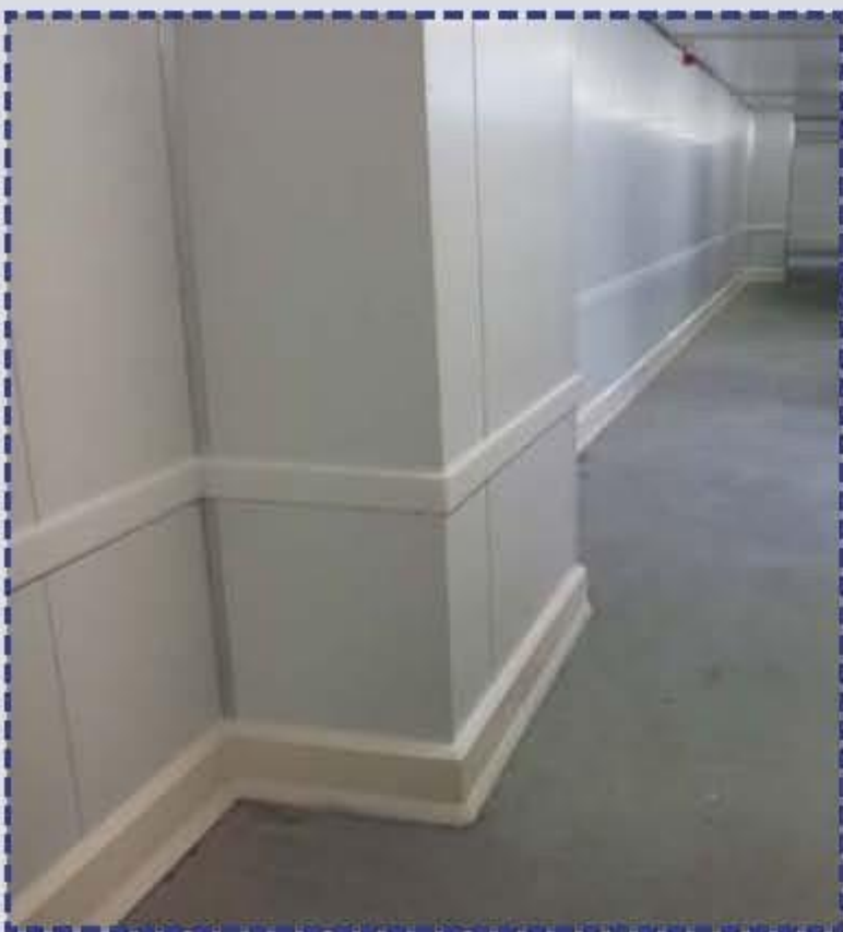
PolySto OP20F instalado en suelo de hormigón con banda PE.
