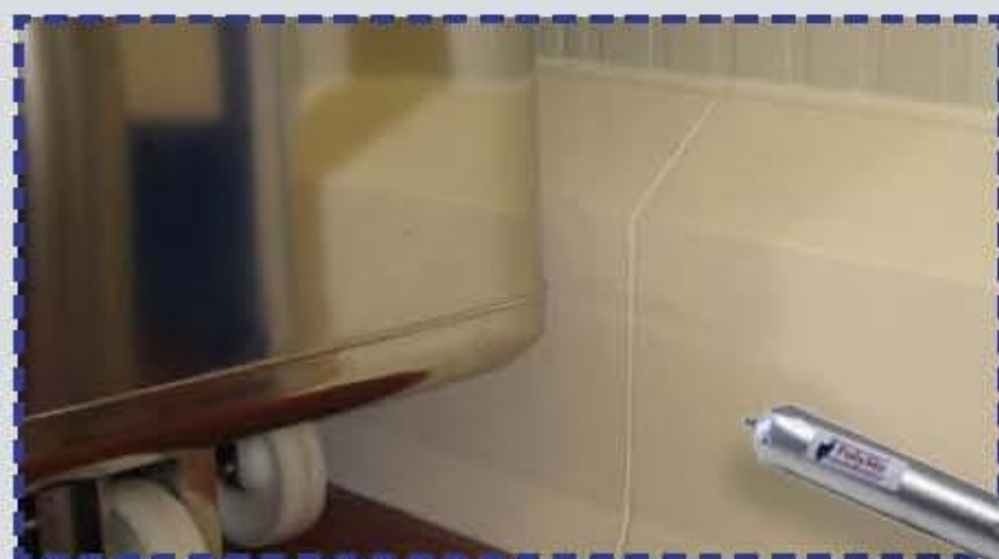
PolySto OP30F instalado en suelo de hormigón y terminado con Silicona PolySto Food Safe.
