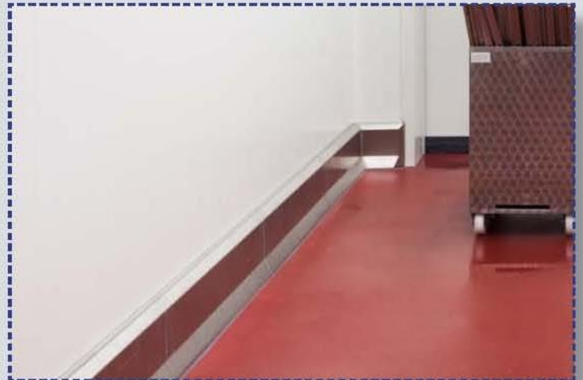
Zócalo PolySto OP20FI de Acero Inoxidable instalado en suelo de epoxy.
