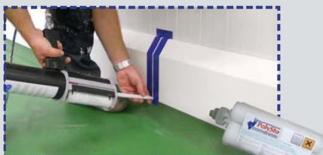
PolySto OP30RB sanicoat con suelo de epoxy aplicado en rebaje y finalizado con PolySto Saniseal.
